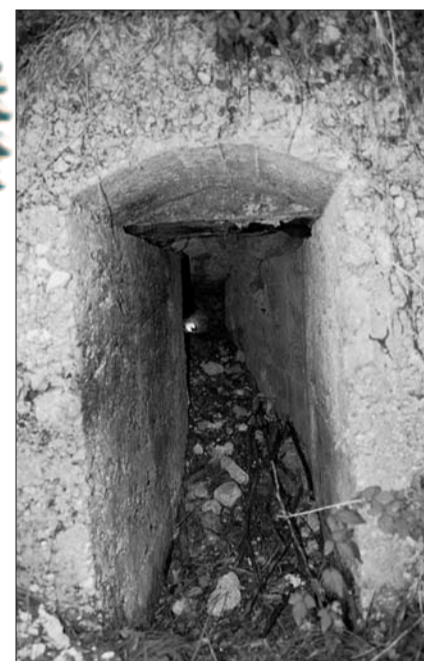
Entrata locali Osservatorio e, a lato, il pallone pressostatico durante un'osservazione e sotto il cunicolo di contenimento con verricello
