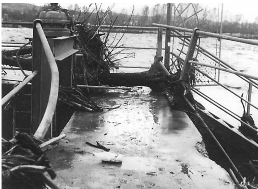
Sopra: effetti dello scavalcamento del picco di piena sulle Opere di Presa del Canale della Vittoria.
