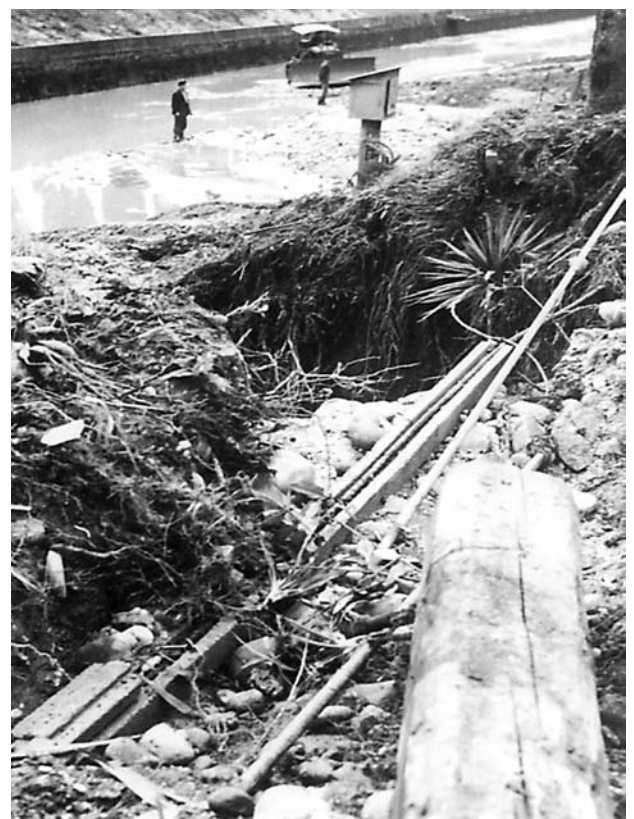
Sopra: effetti dello scavalcamento del picco di piena sulle Opere di Presa del Canale della Vittoria.
